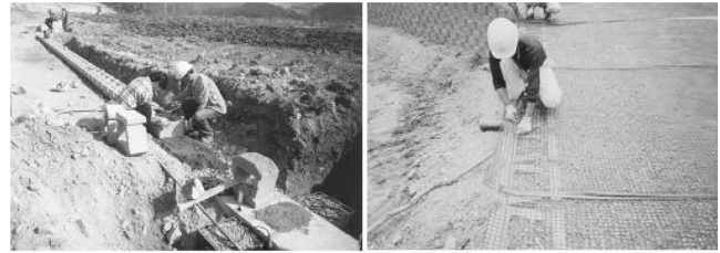
(a) 블록 시공 (b) 지오그리드 포설 및 블록과 연결
