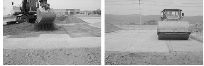
(a) 지오그리드 포설 후 상부성토 모습 (b) 상부 성토재의 다짐 모습
